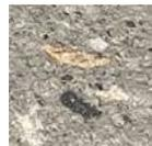
Die Mauerblöcke enthalten 30 Massenprozent Recyclinganteil aus werkseigenem Betonbruch in grober Körnung. Dieses wiederverwertete Material ist bewusst an der Oberfläche sichtbar und verleiht der Mauer eine besondere Optik.
